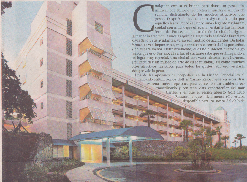
Edificio de cinco pisos que cuenta con 100 nuevas habitaciones con vista al mar.
